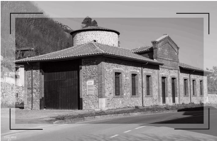
Antigua Escuela del Campo y Torre Medieval
