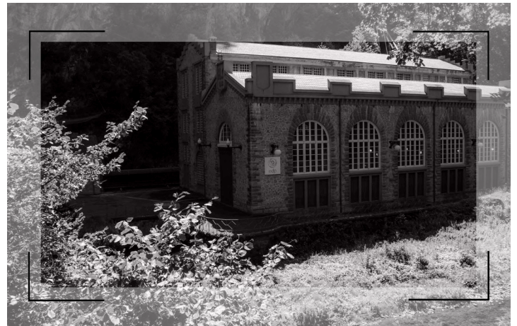
Central Hidroeléctrica (La Malva)
